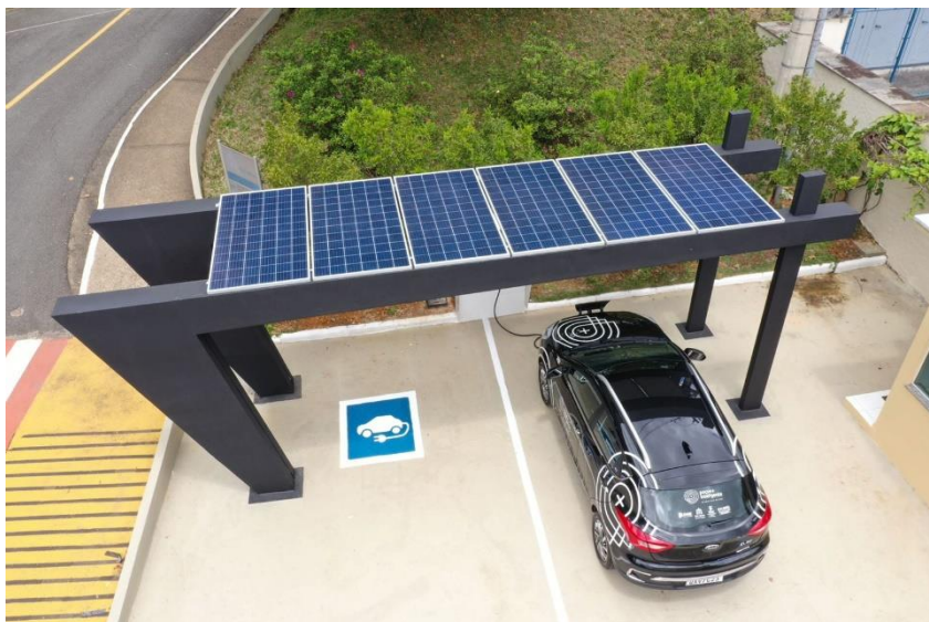
Figura 6 – Ponto de recarga de veículos elétricos
